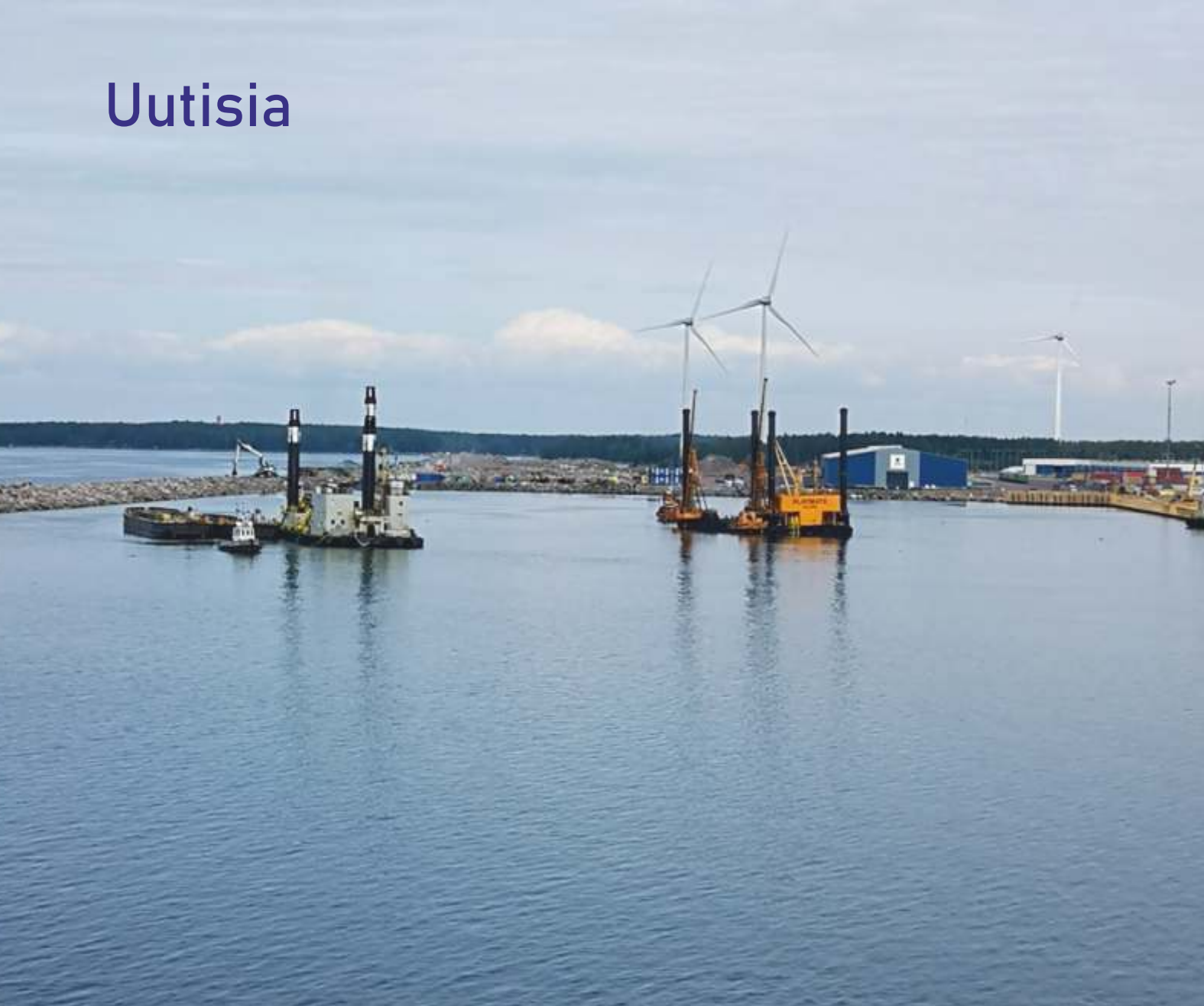
D-alueen rakennus- ja ruoppaustöitä on tehty tiukalla aikataululla koko kuluva vuosi (Kuva TT)
