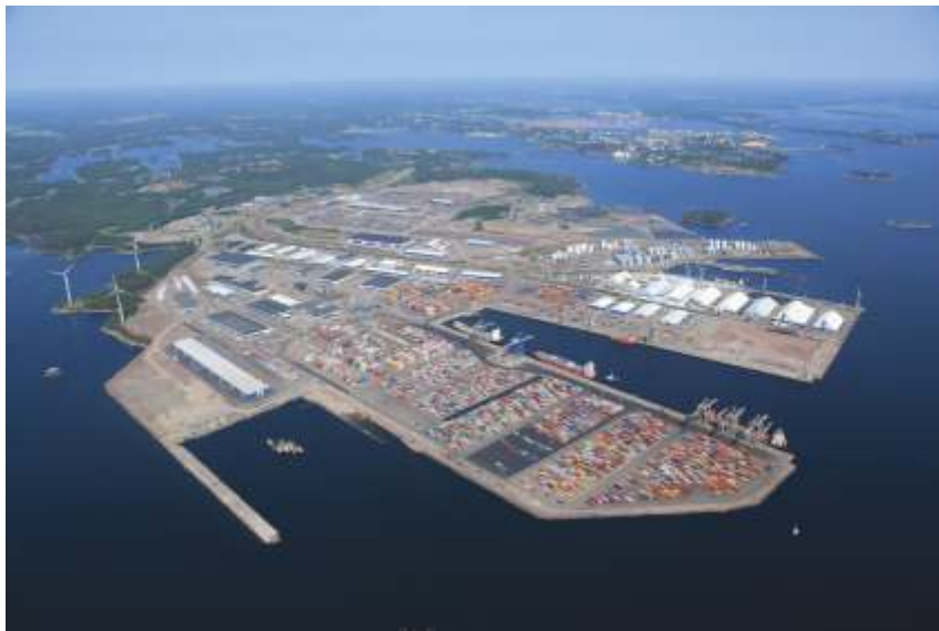
Suomen näkemyksen mukaan älykkäiden järjestelmien käyttöönoton ja automatisoidun liikenteen kannalta Selkeät vastuut ovat älykkäiden järjestelmien käyttöönotossa tärkeitä. Kuva: ©HaminaKotka Satama Oy
