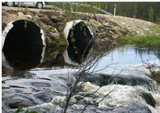
Kuva 84. Tierumpujen asennussyvyys tulee mahdollistaa kaloille esteetön kulku myös alivirtaamakaudella. LAURI KARVONEN.
