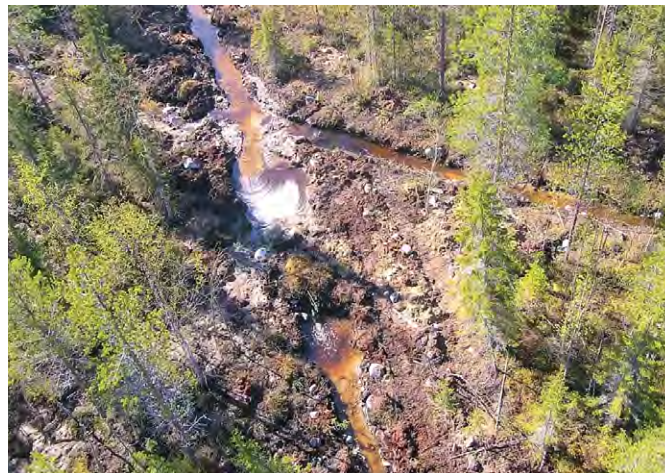
Kuva 80. Virtaamaa säätelevä putkipato ojituskohteella. JURI LAURILA.
