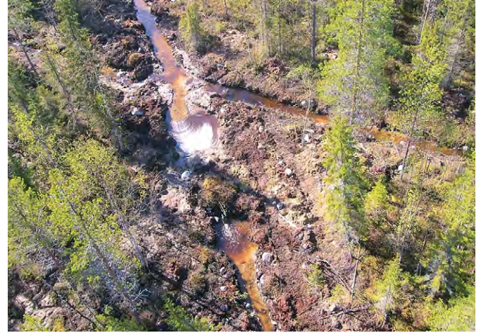
Kuva 80. Virtaamaa säätelevä putkipato ojituskohteella. JURI LAURILA.
