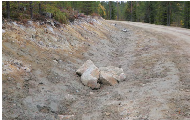
Kuva 85. Kivistä tehdyillä ojakatkoilla voidaan hidastaa veden virtausta ja vähentää ojien syöpymistä. MARKKU TERVONEN.
