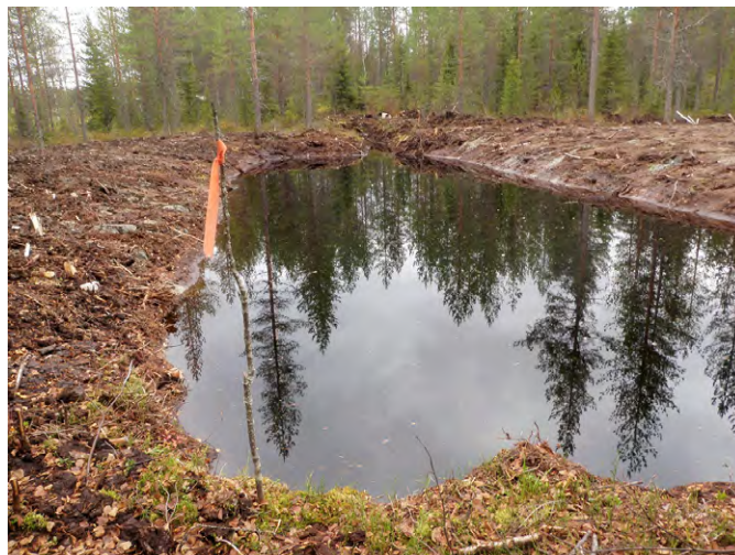
Kuva 82. Laskeutusaltaan kaivumaat tasoitetaan ja ympäristö maisemoidaan kaivutyön jälkeen. MARKKU TERVONEN.
