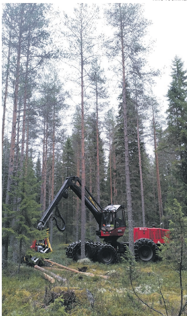
Vierimetsähakkuussa verkkoyhtiö poistaa vaarallisen pitkäksi kasvaneet puut johtoauekan viereltä.
