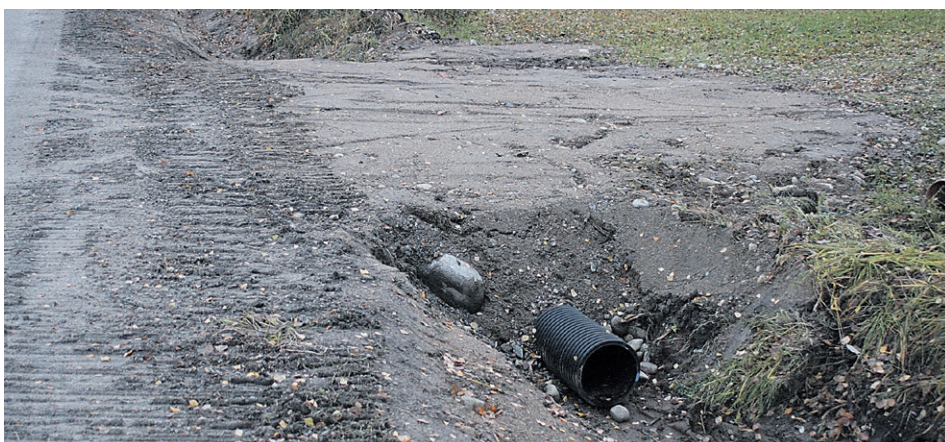
Tienrakennuksen yhteydessä tehtiin uusia rumpuja ja liittymiä ja korjattiin entisiä.
