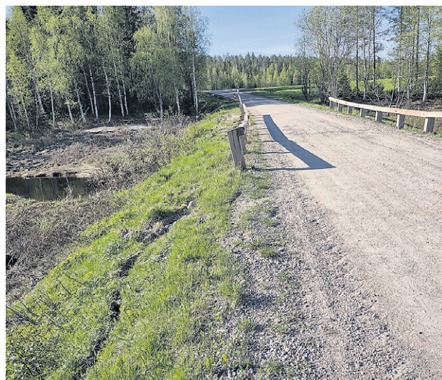
Haukiojan rumpu ennen korotusta
