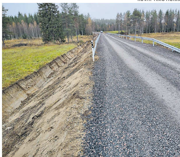
Valmis korotus kaiteineen
