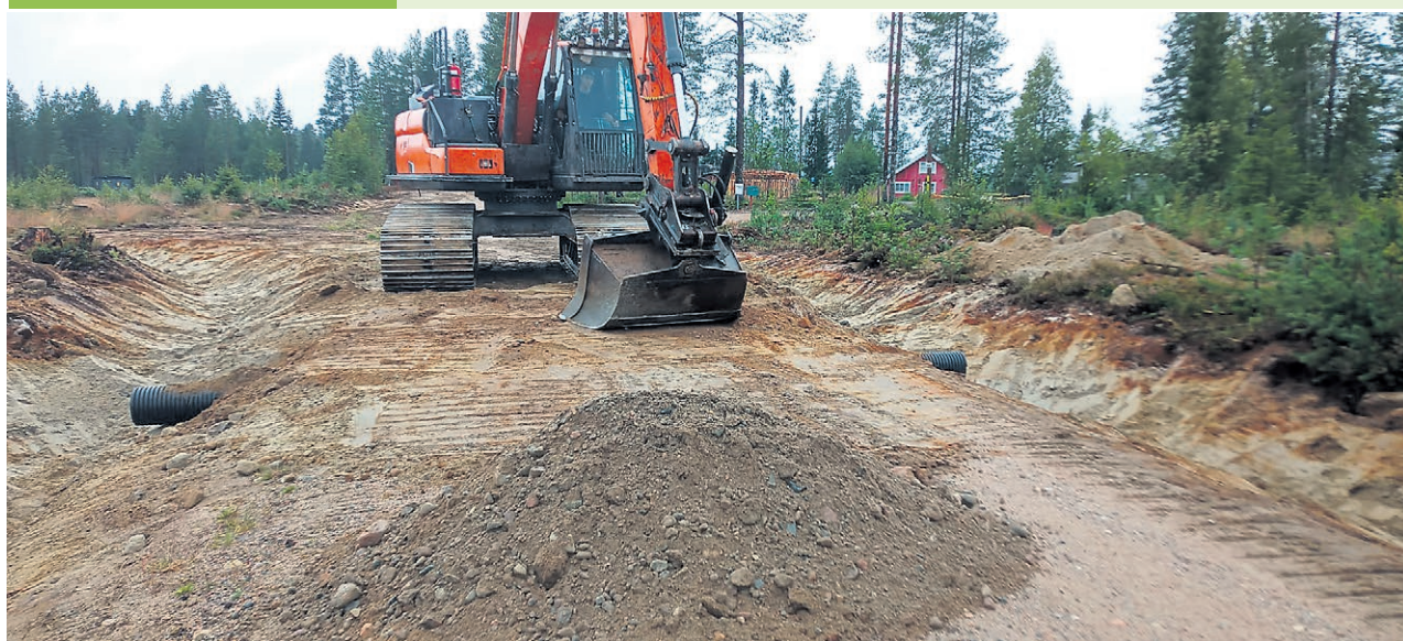
Perusparannuksen yhteydessä vaihdettiin muutama uusi rumpuputki
