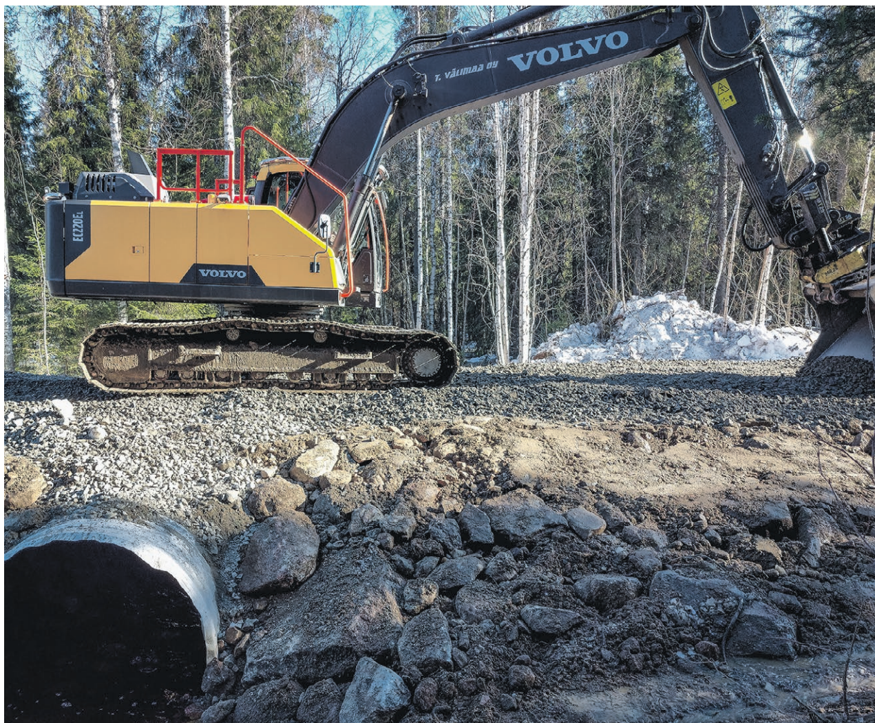
Siltarummun rakentamiseen tai korjaamiseen Metka- tuki on 85%
