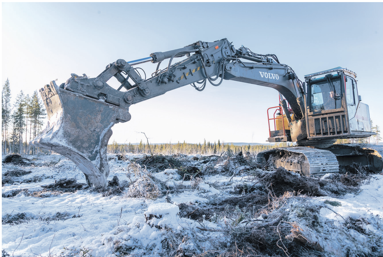
Maanmuokkausta Pellossa loppusyksystä 2024. Työmaata toteuttamassa Ko-La (kuva Ville Saukkoriipi)
