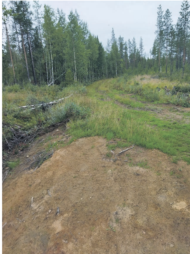
Lannoituksesta kannattaa tehdä "kaikki kuntoon"-projekti. Tässä on laitettu liittymä kuntoon ja parannettu piennartietä, samalla kertaa kun kaivuri kävi palstalla.
