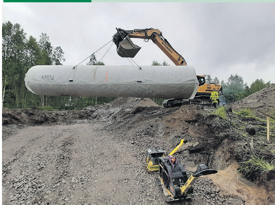
Rumpu on helpompi laittaa paikalleen kuin betonielementtisilta. Kalliita nostureita ei tarvita.
