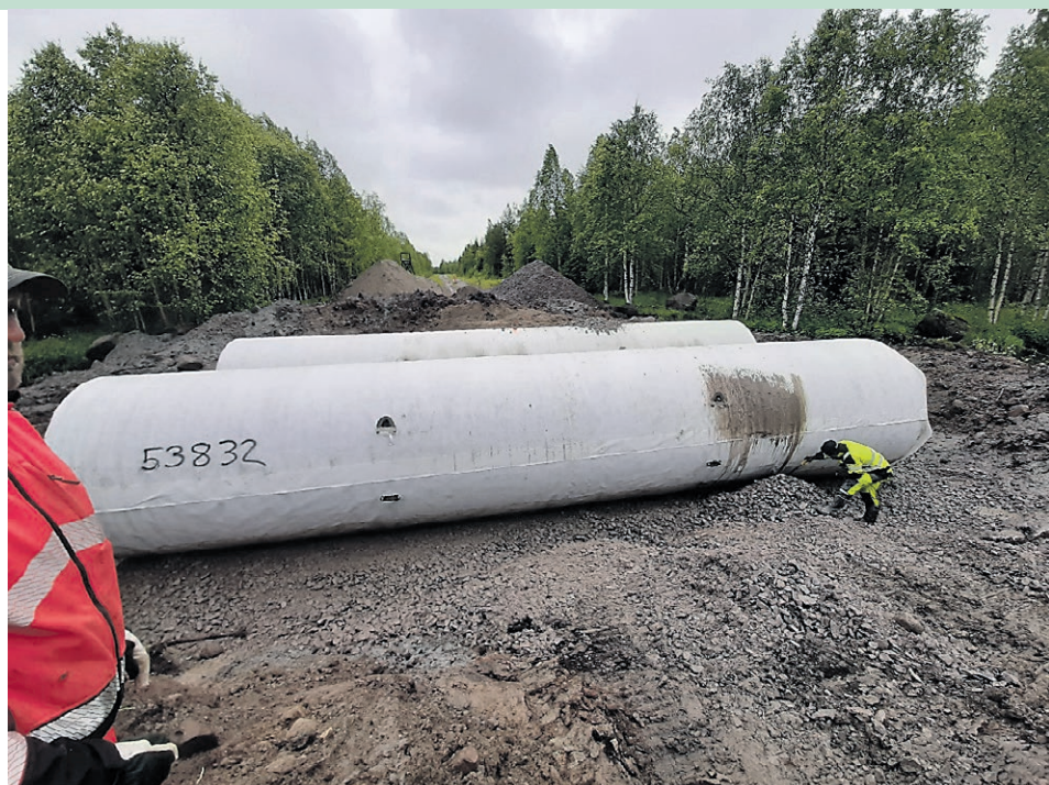
Sivutäytöt tehdään routimattomalla murskeella.
