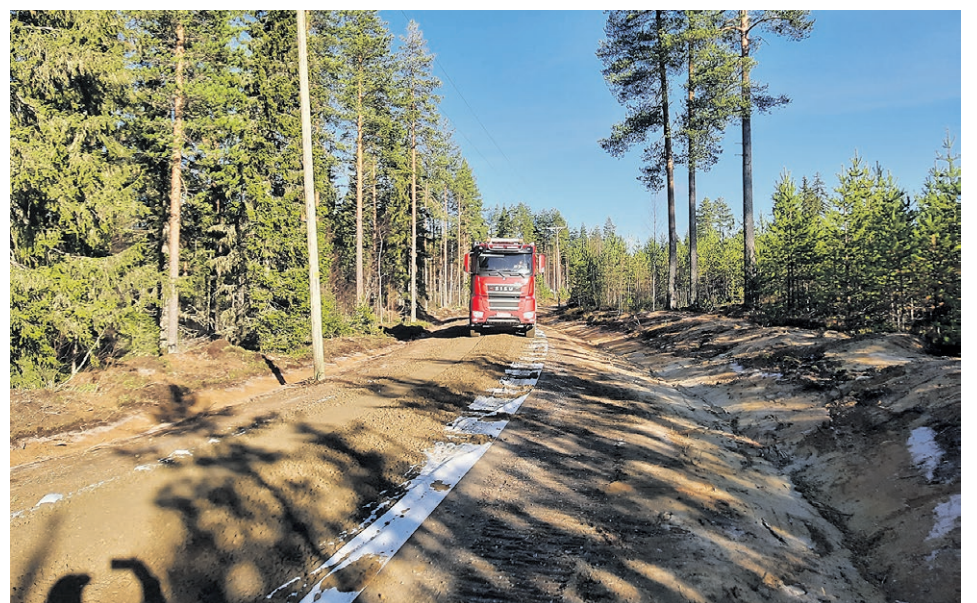
Suodatinkangasta asennettiin ainoastaan tarvittaville paaluväleille. Suodatinkangas estää eri rakennekerrosten sekoittumisen, lujittaa rakenteita ja vähentää routavaurioita. Murskeet toimitti Maaselän maatalouspalvelu Oy.
