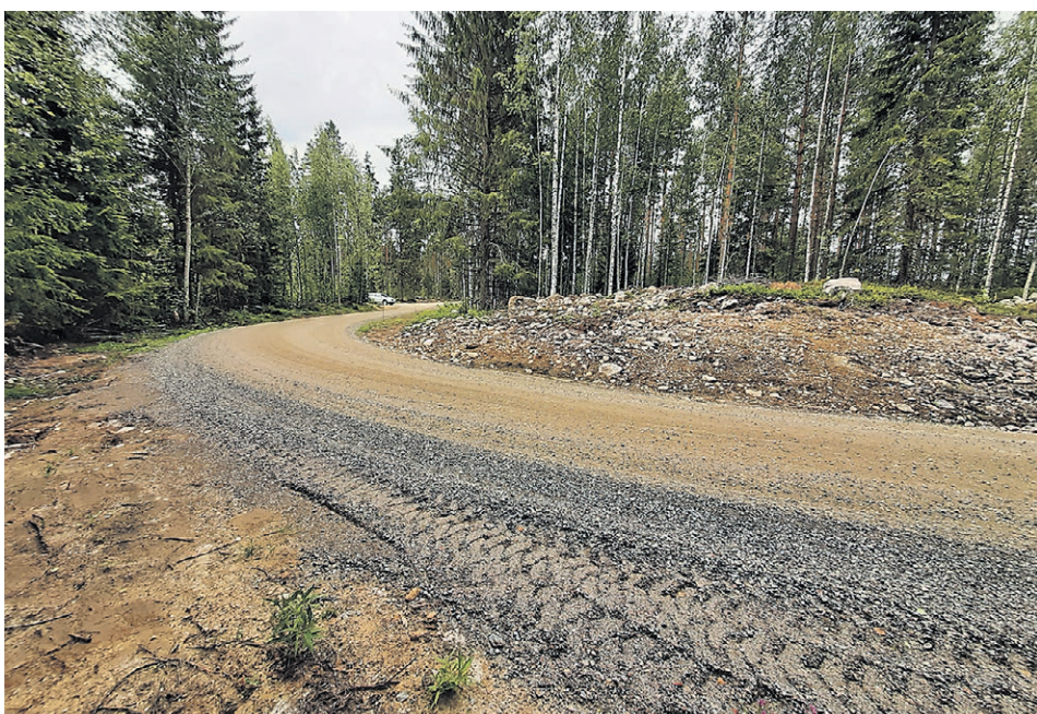
Jyrkimpiä mutkia oikaistiin ja maaston näkemäesteitä poistettiin maastoa leikkaamalla.
