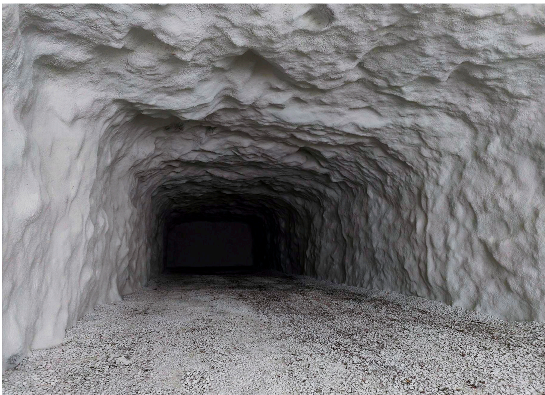
Saharannan luolaan tulevan sähköaseman on tarkoitus valmistua kesään 2026 mennessä. Kuva: Naantalin Energia
