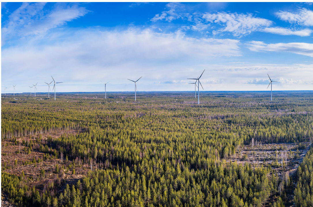
Naantalin Energia vahvistaa tuulivoimatuotantoaan osakkuusyhtiöiden kautta. Kuva: Puhuri Oy
