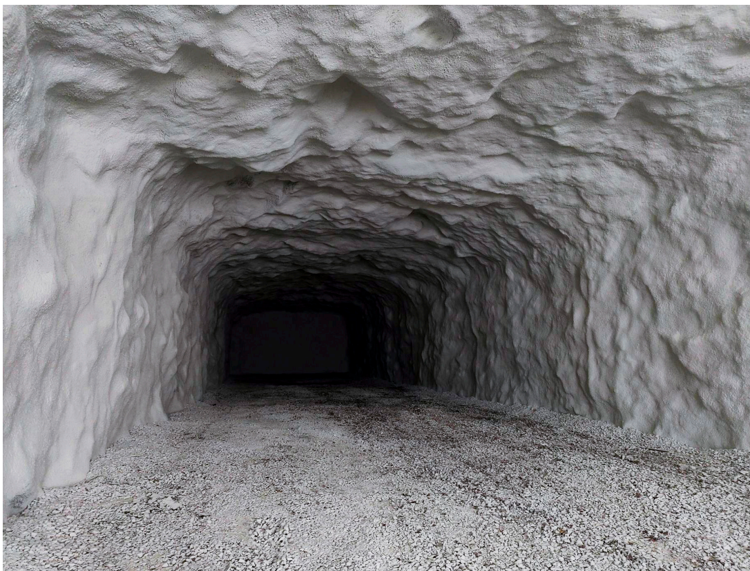
Saharannan luola odottaa rakennustöiden aloittamista. Luolaan rakennetaan uusi sähköasema, joka parantaa sähkön toimitusvarmuutta koko kaupungissa. Kuva: Naantalin Energia
