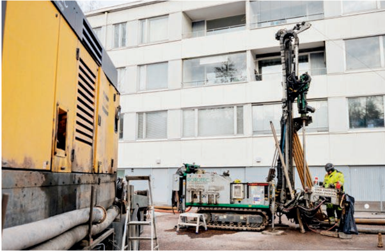
Rototecin ammattilainen poraamassa maalämpökaivoa kerrostalon edustalla. Suurissa kohteissa korostuvat huolellinen suunnittelu ja asiantuntemus.
