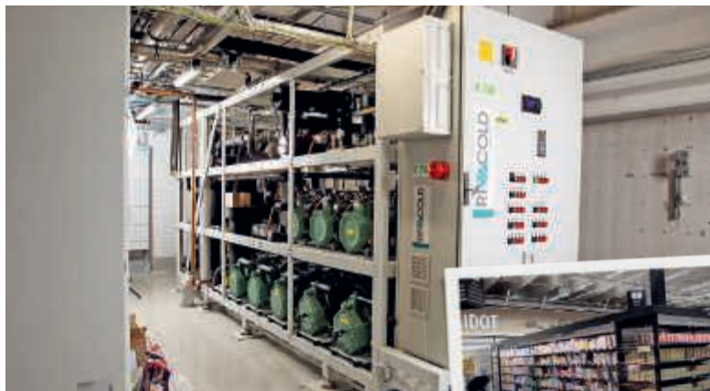
Vantaa Tammiston K-Citymarketin juuri uudistettu kylmätekniikka perustuu Rivacold-hiili-dioksidikoneisiin. Urakoinnin toteutti FCool Oy.
