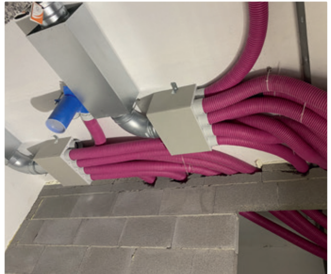
Plastventilatsioon jääb algusest lõpuni ühepaksuseks ning ei lisandu metallile omast „kuuseefekti”
