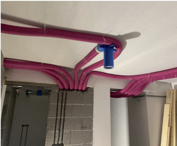
Plastventilatsioon jääb algusest lõpuni ühepaksuseks ning ei lisandu metallile omast „kuuseefekti”
