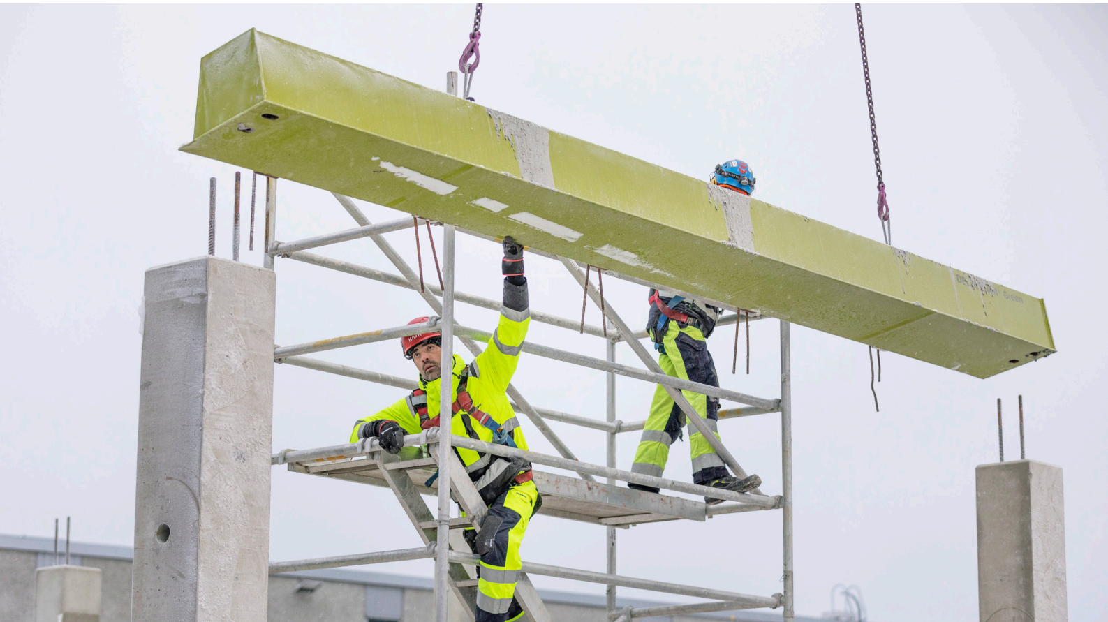
▲ DELTABEAM® Green -palkin asennus betonipilarin päälle.
