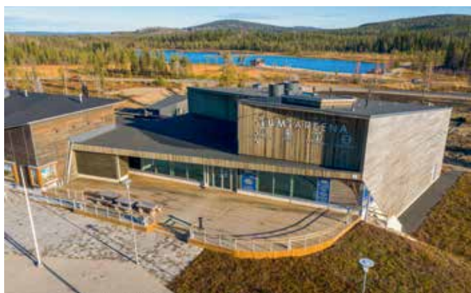
LumiAreena on Syötteen matkailukeskuksessa sijaitseva Pudasjärven kaupungin omistama tapahtumakeskus. Moderni julkinen hirsirakennus valmistui vuoden 2019 lopulla.
