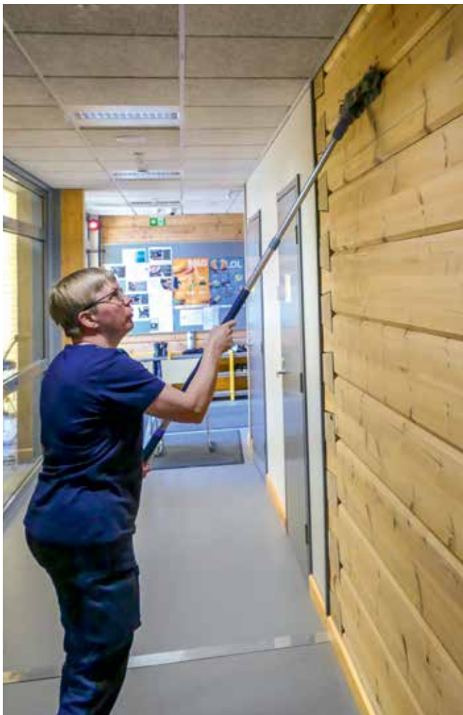
Hirsiin ja niiden väleihin kertyvä pöly puhdistetaan kuivalla mopilla. Siivooja Leila Seppänen näyttää, miten hirsiseinien perussiivous kesällä tapahtuu: "Aloitan ylhäältä hirsi kerrallaan eli kuljetan moppiä hirren suuntaisesti työskentelysuuntaan ja siirryn sitten alempiin hirsiiin."
