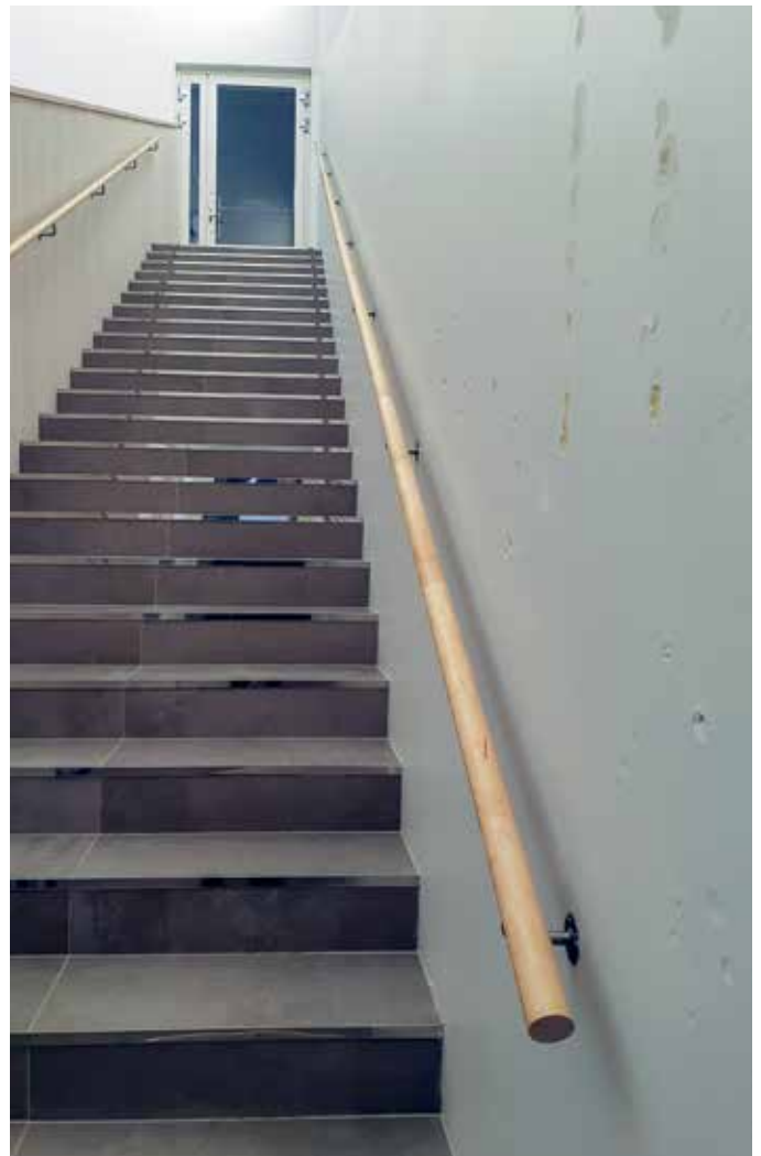
Aulan yleisilme siistiytyi, kun seinien akustoiva materiaali vaihdettiin jo lyhyen käytön jälkeen. Akustiikkaseinä ei kestänyt pienintäkään painallusta eikä pyyhintää. Jo ensimmäisten toimintaviikkojen aikana seinään ilmaantui painaumia, tahroja ja sormenjälkiä, joita ei voinut puhdistaa. Valoaulassa haasteita tuo myös yläpölyjen poisto.
