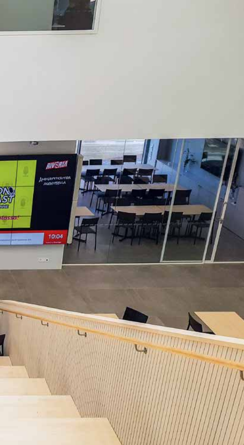
Aulan yleisilme siistiytyi, kun seinien akustoiva materiaali vaihdettiin jo lyhyen käytön jälkeen. Akustiikkaseinä ei kestänyt pienintäkään painallusta eikä pyyhintää. Jo ensimmäisten toimintaviikkojen aikana seinään ilmaantui painaumia, tahroja ja sormenjälkiä, joita ei voinut puhdistaa. Valoaulassa haasteita tuo myös yläpölyjen poisto.
