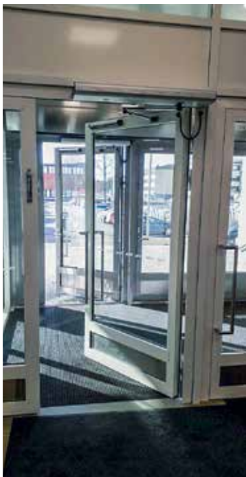
Rakennuksen sisään-tuloon on kiinnitetty suunnittelussa ja toteutuksessa hyvin huomiota. Lian sisälle tuloa vähentää iso tuulikaappi ja ovimatot sekä laatoitettu piha-alue.
