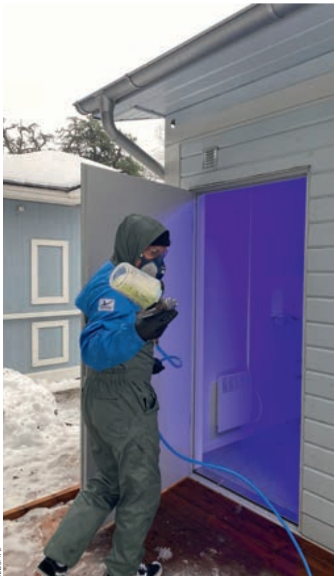
Asentaja ruiskuttaa nanopinnoitetta Hangon kirkkopuiston yleisön wc-tiloihin. Taustalla tilassa näkyy sininen desinfiointivalo.
