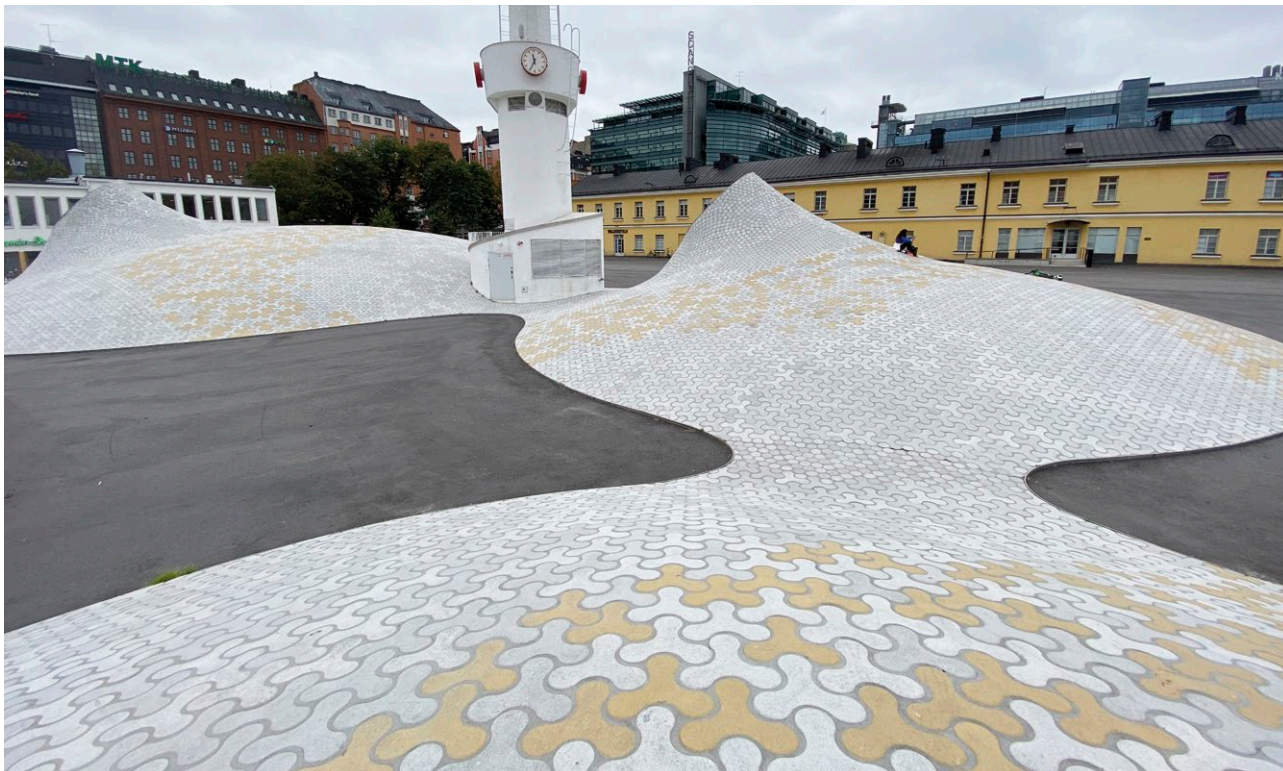
Amos Andersonin uuden museon maanpäälliset rakenteet elävöittävät Lasipalatsinaukiota. Sipti vastasi kohteen rakenne- ja pohjarakennesuunnittelusta.
