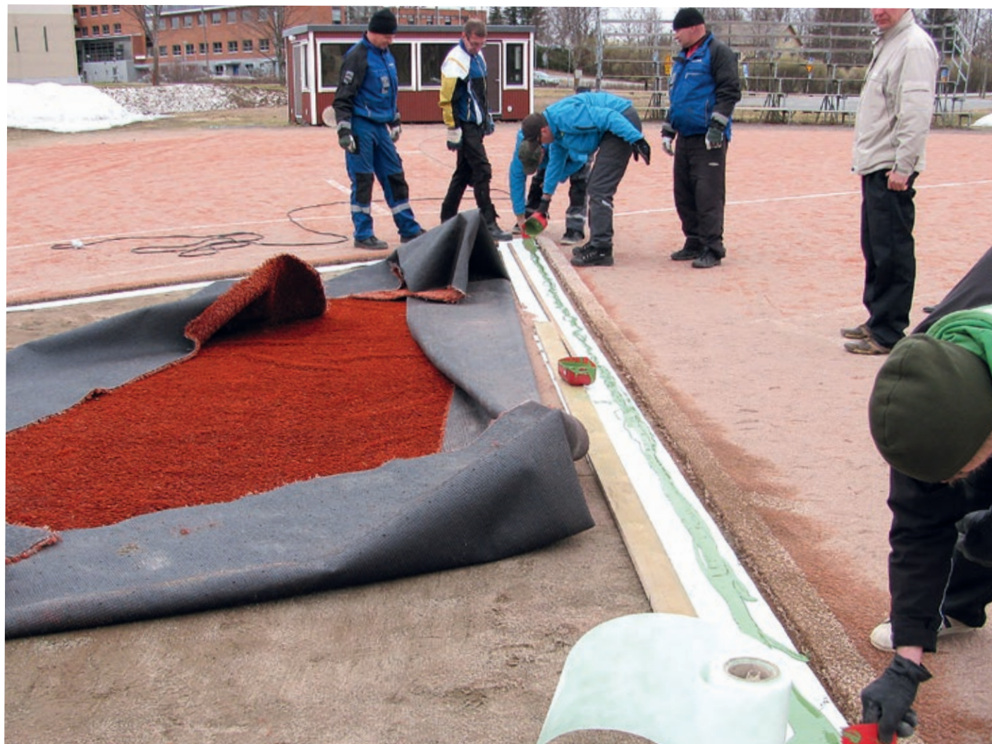
■ Pesäpallokentän tekonurmen kotipesän korjaamistoimenpiteet käynnissä.
