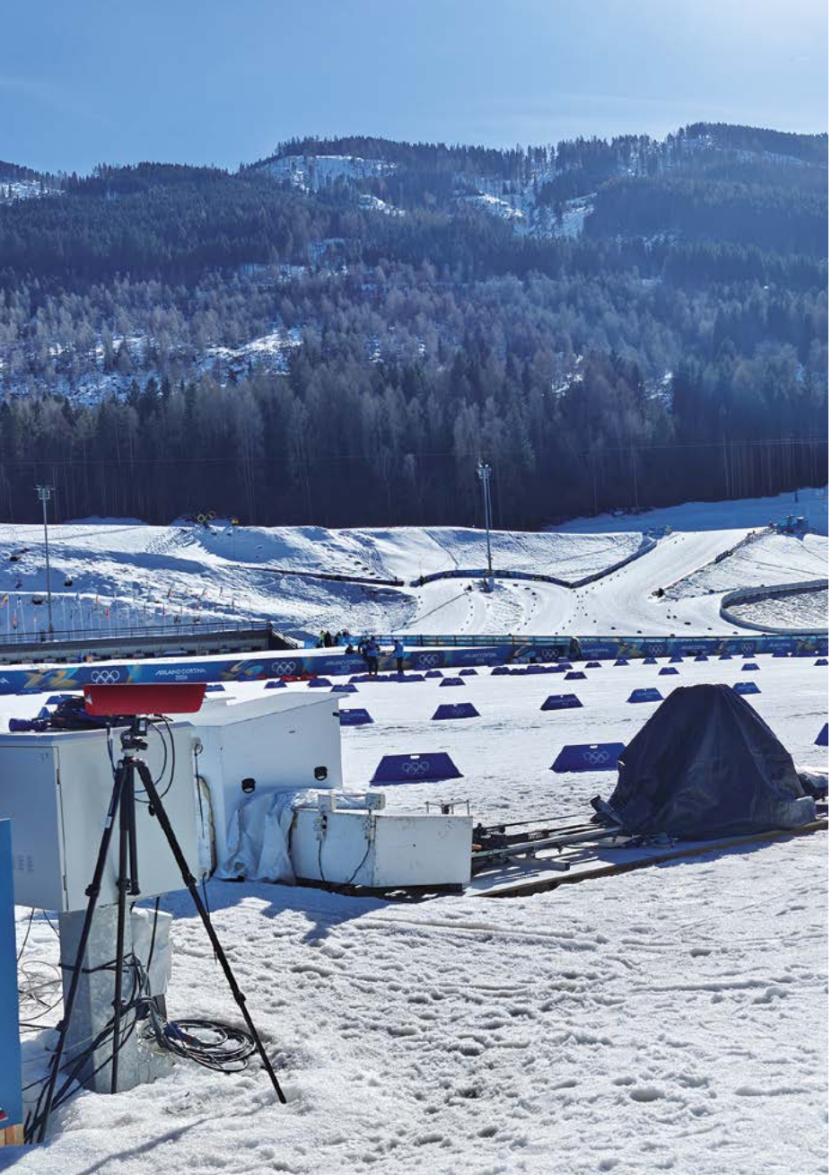
Stadionille ja ratojen varteen rakennettiin 386 km lumen ja maan alla kulkevia nvalokuituyhteyksiä ja muuta tekniikkaa tapahtumatuotannon mahdollistamiseksi.
