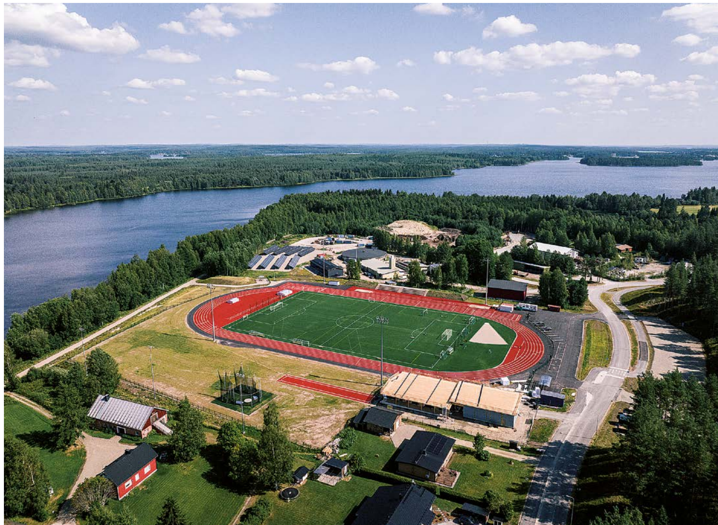
Mustolan uutta urheilukenttää päästiin käyttämään kesällä 2025. Tulevalle kesälle sinne on valmistunut huoltorakennus.
