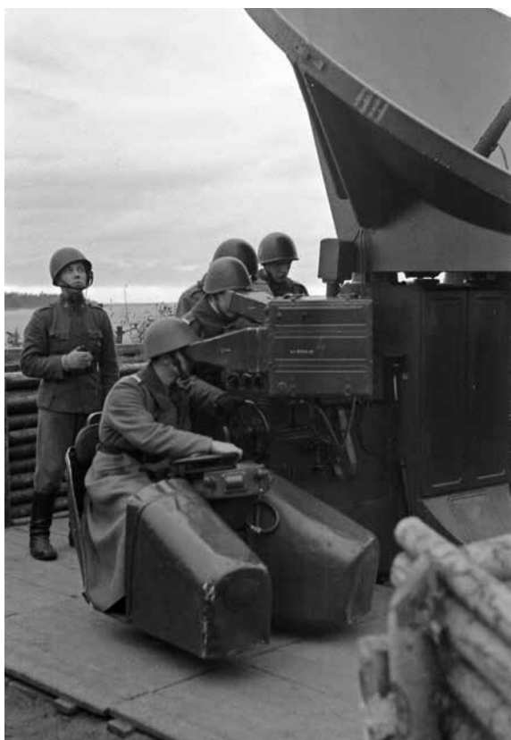
Tutka oli II MS:n tärkeimpiä keksintöjä. Saksalainen tulenjohtotutka FuMG 39T "Irja" mahdollisti yöpommittusten tehokkaan torjunnan Helsingissä ja Kotkassa helmikuussa 1944. (SA-kuva)
