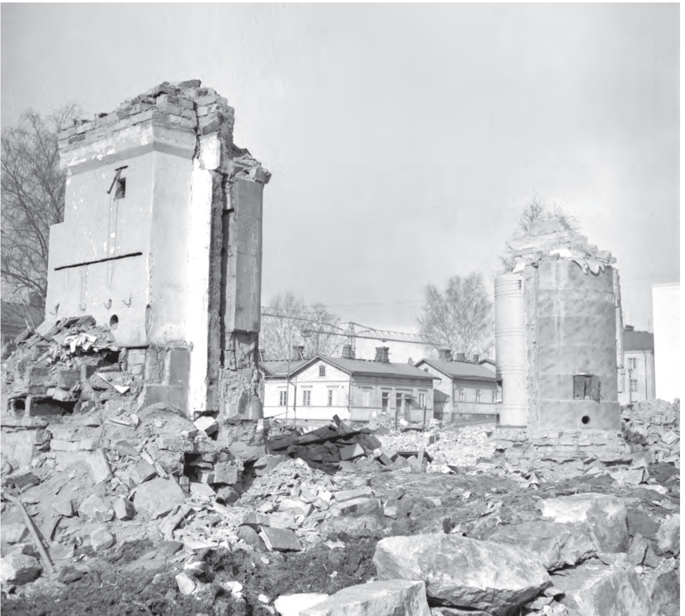
Viimeisenä jäivät pystyyn tulisijat ja piiput. Purkutyömaat tulivat ensin Amurin reunoille; itään ja länteen.
