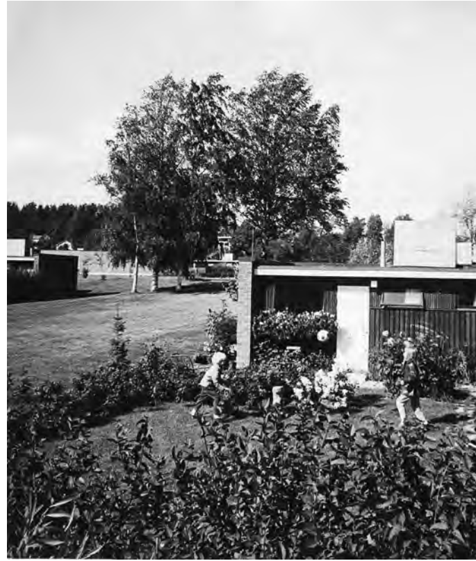
Puisto-Kaarilan pientaloalue valmistui vuonna 1967 ja se käsittää 71 asuntoa, joihin kuhunkin liittyy myös talousrakennus.
