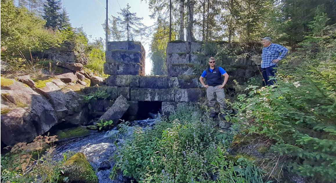
Virtavesikunnostukset ja kalojen noususteiden poistaminen vaati maan- ja vesialueiden omistajien suostumukset. Oriveden Pajujoen massiivista patoa on katselmoimassa KVVY:n Sami Ojala ja paikallinen aktiivi Leo Seppälä.
