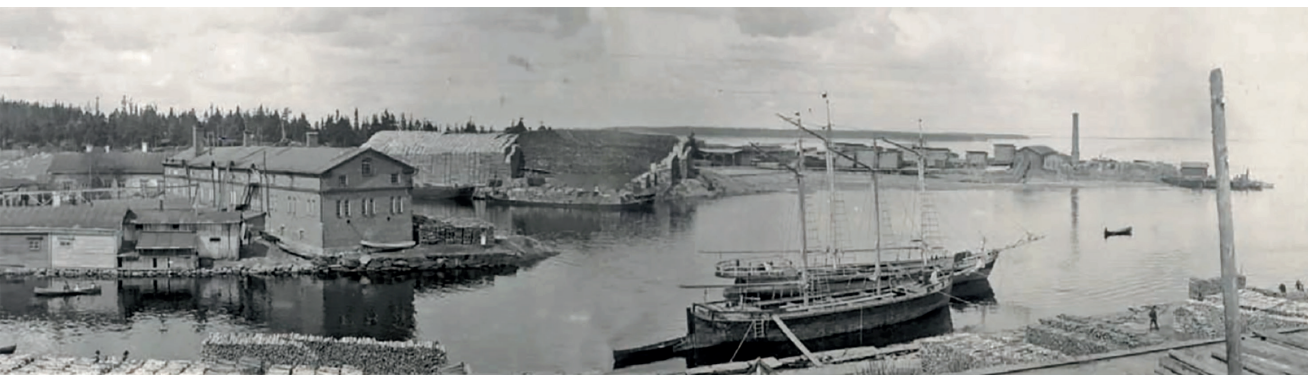
Mustalahti ja Kortelahti kuvattuna kohti Särkänniemeä noin vuonna 1900. Kuvan etuosassa Mustalahdessa on halkojaaloja kiinnitettynä laituriin. Kuvan keskiosassa on Mustalahden panimon rakennus ja taustalla Särkänisaaren sahan rakennuksia nykyisen Särkänniemen huvipuiston alueella. Kuva: E.M. Staf/Vapriikin kuva-arkisto.
