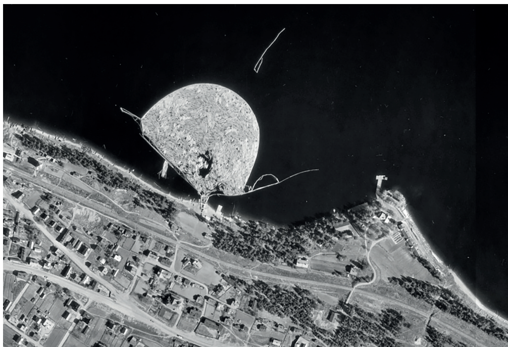
Ote ilmakuvasta vuodelta 1946 uittotunnelin ja Pölkylänniemen alueelta. Suuri tukkilautta on kiinnitetty uittotunnelin edustalle. Järven pohjaan on ankkuroituna uittojohteita ohjaamaan tukkeja ja pitämään niitä paikoillaan. Pölkylänniemen kärjessä on suuri laituri. Kuva: Tampereen kaupunki.
