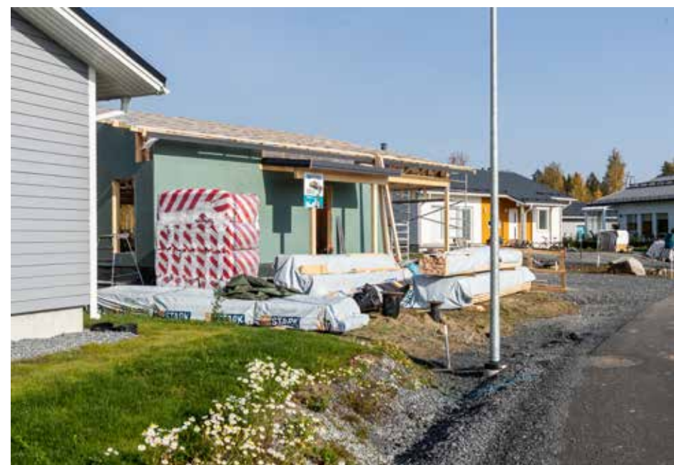
Siltatien alueen kunnallistekniikkaan ja tonttitarjontaan panostetaan lähivuosina paljon. Siltatien kouluhanke etenee ripeästi kilpailutuksen kautta toteutukseen. Rakentaminen käynnistyy alkuvuodesta 2022.
