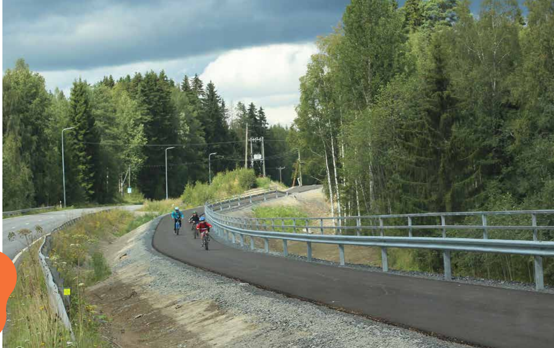
Takamaalle rakennettiin kesällä 3,7 kilometriä upeaa, pyöräilyyn kannustavaa kevyen liikenteen
